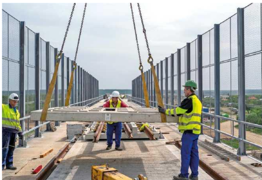
Rozbudowa sieci kolejowych trwa w całej Europie © PORR
