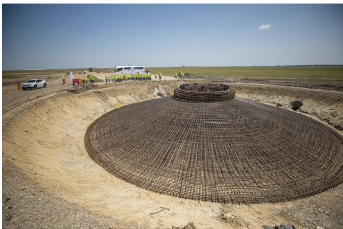
PORR zrealizuje 42 fundamenty i platformy z tłucznia © Rezolv Energy
