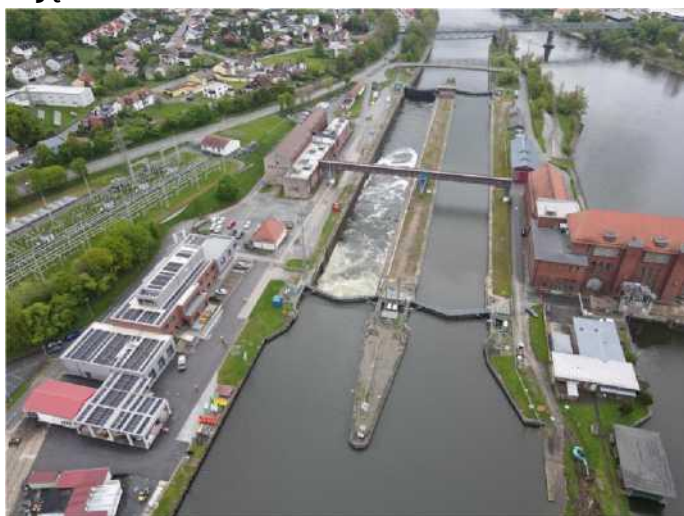
Śluza Kachlet wymaga gruntownej modernizacji © HABAU / Norbert Enders
