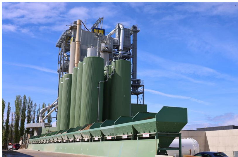
Wytwórnia mieszanek asfaltowych PORR w Wiedniu-Simmering © PORR
