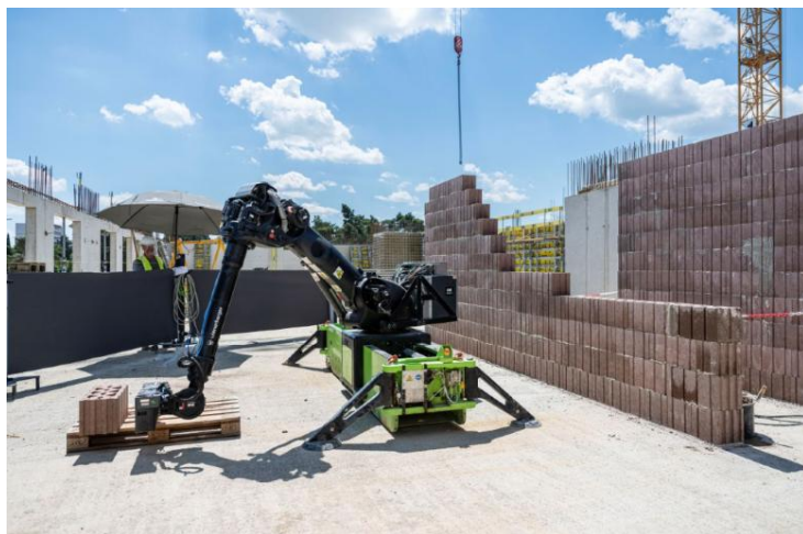
Walter potrafi podnosić cegły o wadze do 52 kg © PORR/Jan Hrdý
