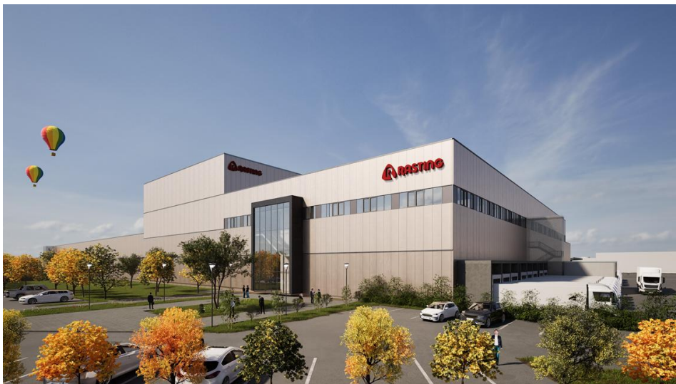
PORR buduje nowy zakład przetwórstwa mięsnego dla sieci EDEKA w Meckenheim © PGSJ Planungsgesellschaft mbH
