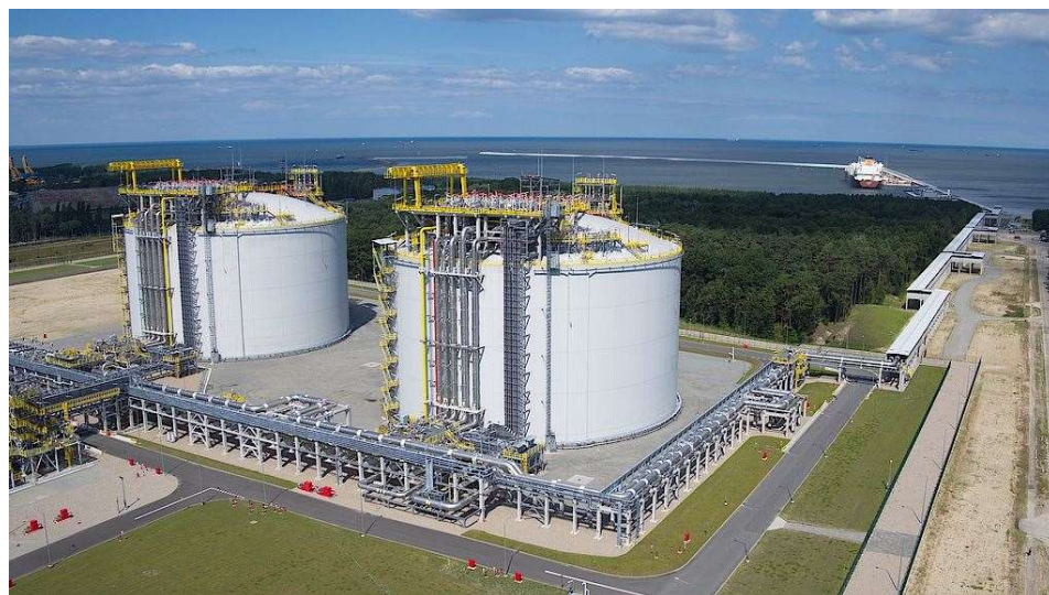
Terminal LNG w Świnoujściu (© Polskie LNG)
