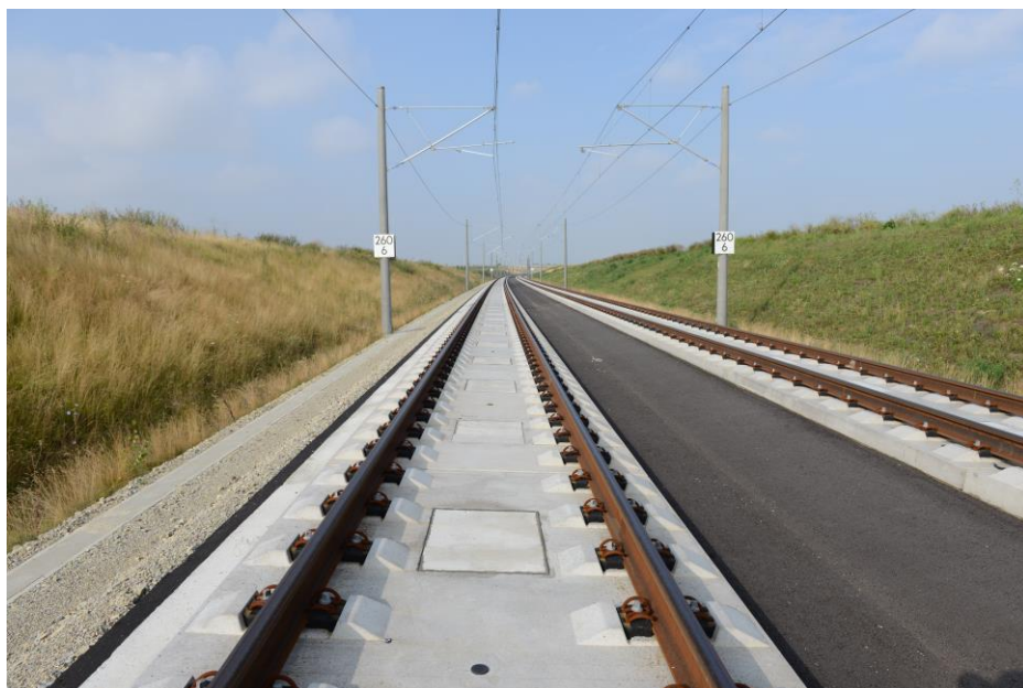
Technologia Slab Track Austria jest pomyślnie wdrażana w Europie i Azji na kolejowych projektach szybkobieżnych i renowacyjnych (Copyright: © PORR)
